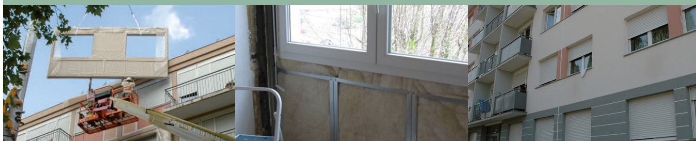
Le doublage intérieur sera fixé sur des rails indépendants de la façade pour permettre un fonctionnement « masse ressort masse »
