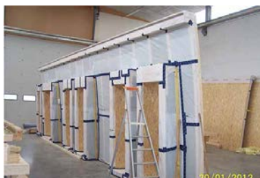
Les façades galbées sont réalisées en atelier, avec l'isolant et le pare-vapeur.
