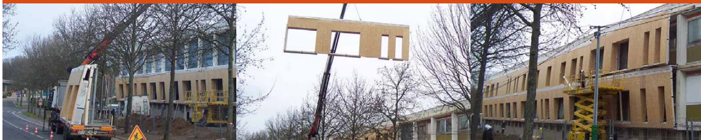
Le bâtiment situé le long de la voirie ne permet pas le stockage
