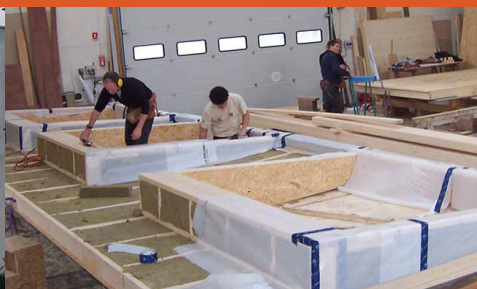
Les façades en cours de préfabrication dans l'atelier
